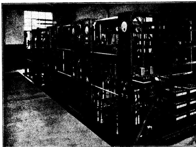
STAZIONE TRASMITTENTE A FASCIO DI BRIDGWATER COSTRUITA DALLA MARCONI'S WIRELESS TELEGRAPH COMPANY LTD. PER L'UFFICIO GENERALE POSTE INGLESÌ SU SISTEMA MARCONI ONDE CORTE.
