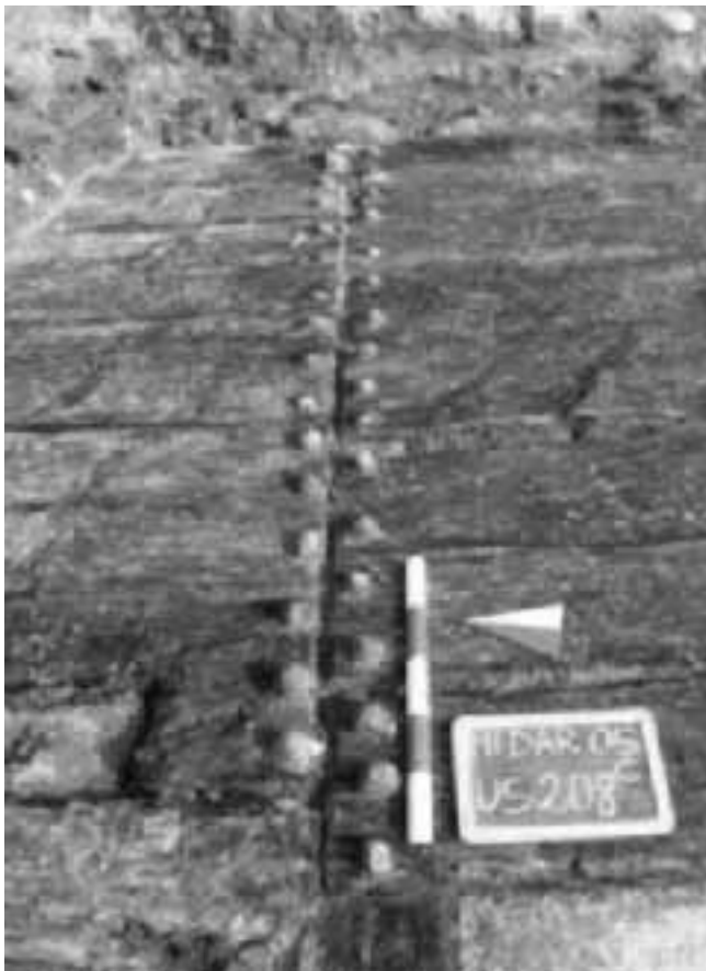
99 - Milano, Darsena di Porta Ticinese. Particolare dei chiodi di ferro che fissano le tavole dell'assito ligneo.
